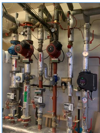
Obrázok 12: Zrekonštruované merače a termohlavice
