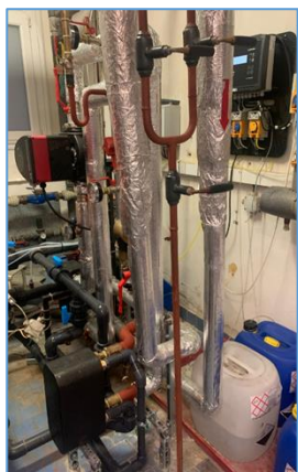
Obrázok 12: Zrekonštruované merače a termohlavice
