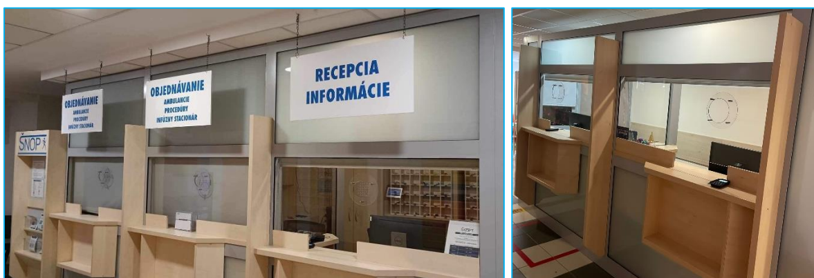
Obrázok 14: Zrekonštruované pracovisko recepcií na prízemí a 2. poschodí
